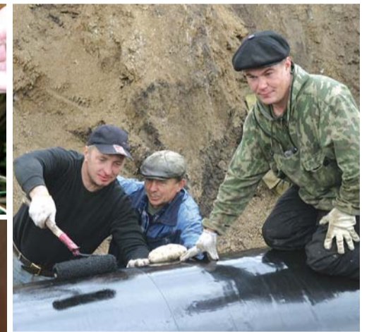
Изолировщик Борис Ивлев «укутывает» трубу
